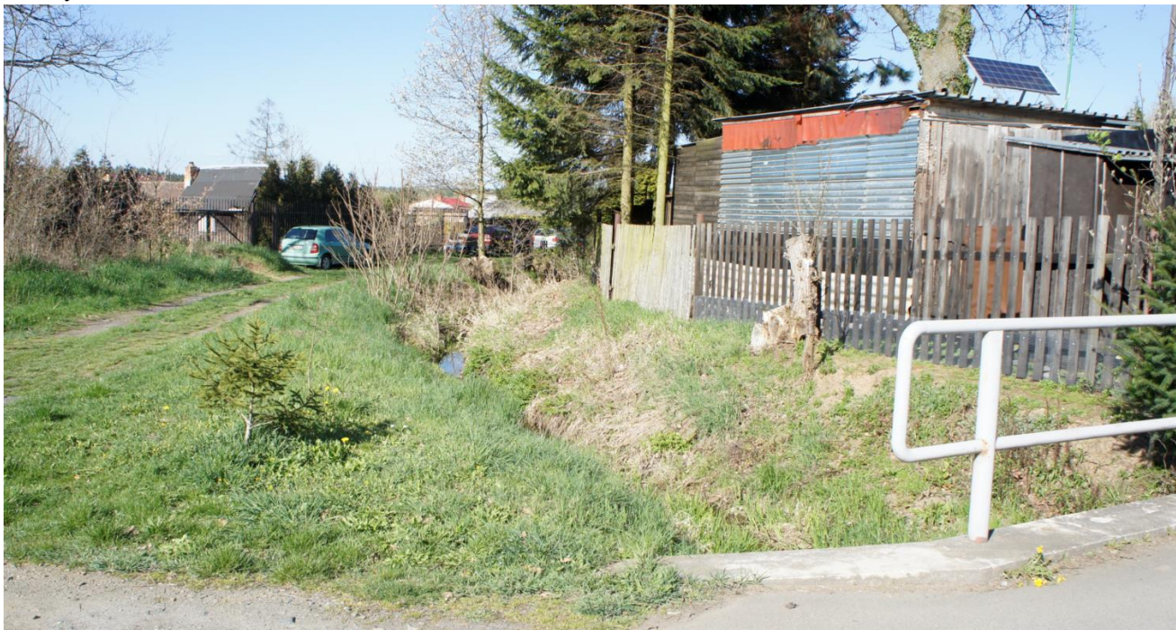
Obrázek 9. Za propustkem pod místní komunikací Sytno - Lhota u Stříbra protéká Sytný potok zahradami. Na pozemku parc. č. 1391 k.ú. Sytno se nacházejí objekty bez zákresu v katastrální mapě. Pro převedení vod při vyšších stavech je pod propustkem navrženo rozšíření koryta jižním směrem.
