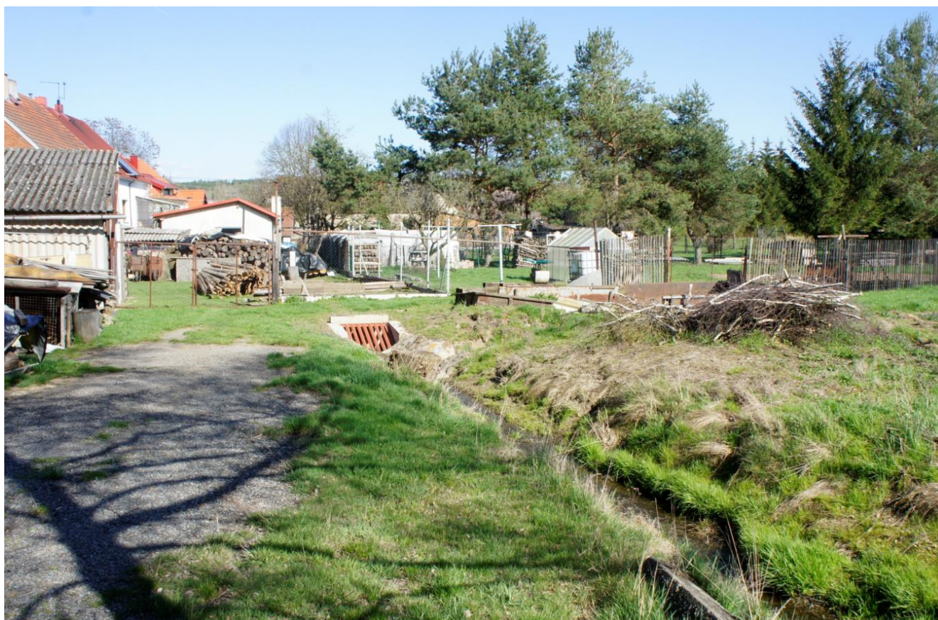
Obrázek 13. Horská vpust (s odtokem do potrubí DN 400 přes zástavbu do vodoteče) na pozemku parc. č. 1118/1 k.ú. Sytno
